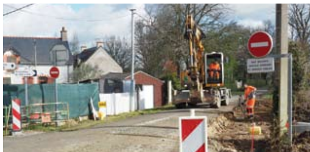
Route d'Issé / 6 mars Travaux d'aménagement d'une liaison douce et d'une chaudière pour sécuriser les déplacements.
