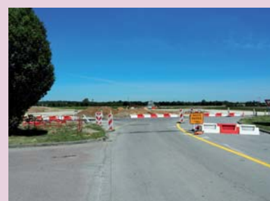
Travaux de contournement mené par le Département de Loire-Atlantique
