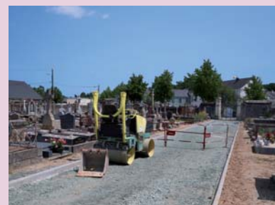
Aménagements des allées du cimetière
