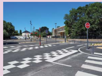
Aménagements des abords du collège
